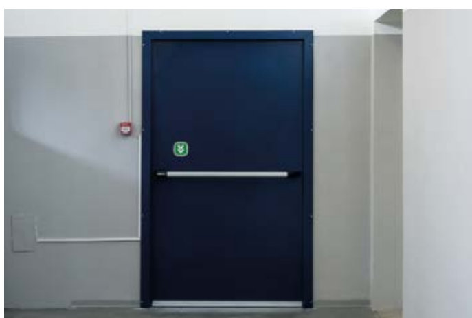
Modello tagliafuoco corredato di maniglione push interno.
